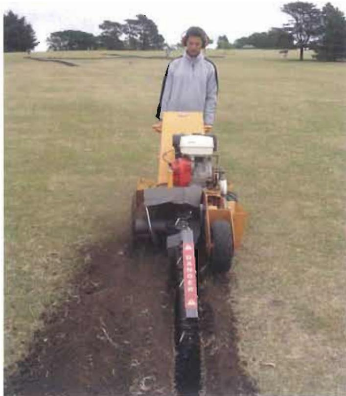
Zanjeadora realizando trabajos para red de riego en una cancha de la Federación
